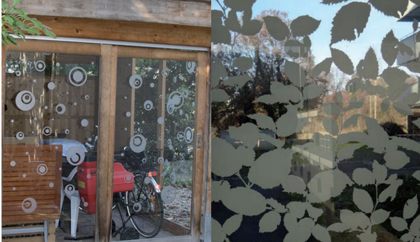
Dem Schutz vor Tierfallen in Siedlung und Landschaft war der Schwerpunkt der BirdLife-Kampagne «Biodiversität im Siedlungsraum: Natur vor der Haustür» gewidmet. Hier Methoden, um Glas für Vögel sichtbar zu machen.
